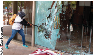
VANDALISMO en la Torre del Bienestar.
